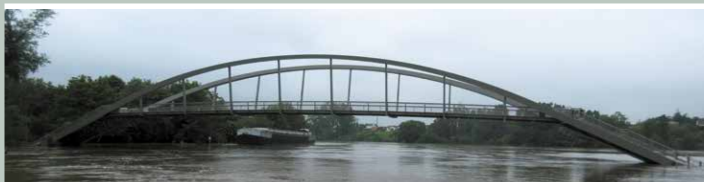
La nouvelle passerelle entre Saint-Mammès et Veneux-Les Sablons
